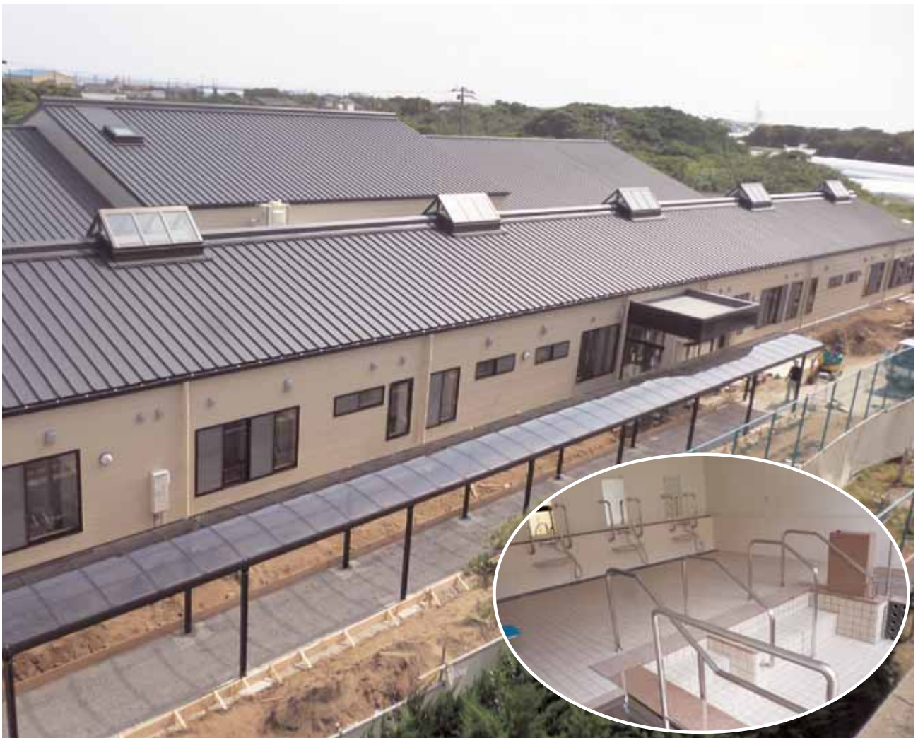
本年7月1日に開棟した海上寮療養所新暁の星病棟（右下は本病棟内浴室）
