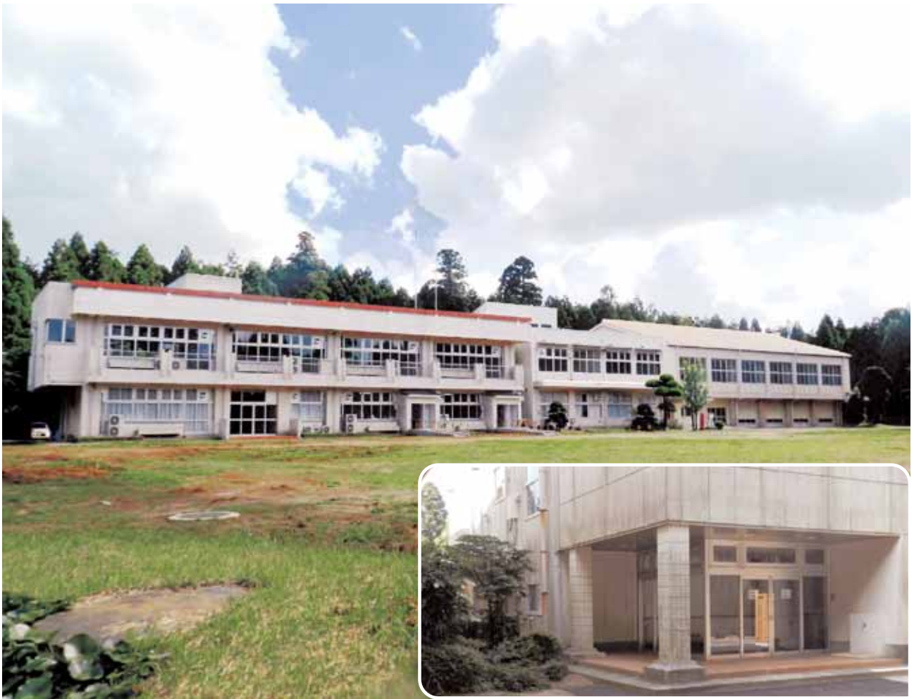
高萩福祉センター全景（右下は正面玄関です）
